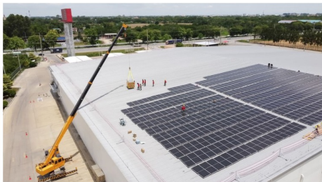
Auf den Dächern von Lager- und Gewerbehallen werden Photovoltaikanlagen installiert (Symbolbild) © Foto: navitar / stock.adobe.com
